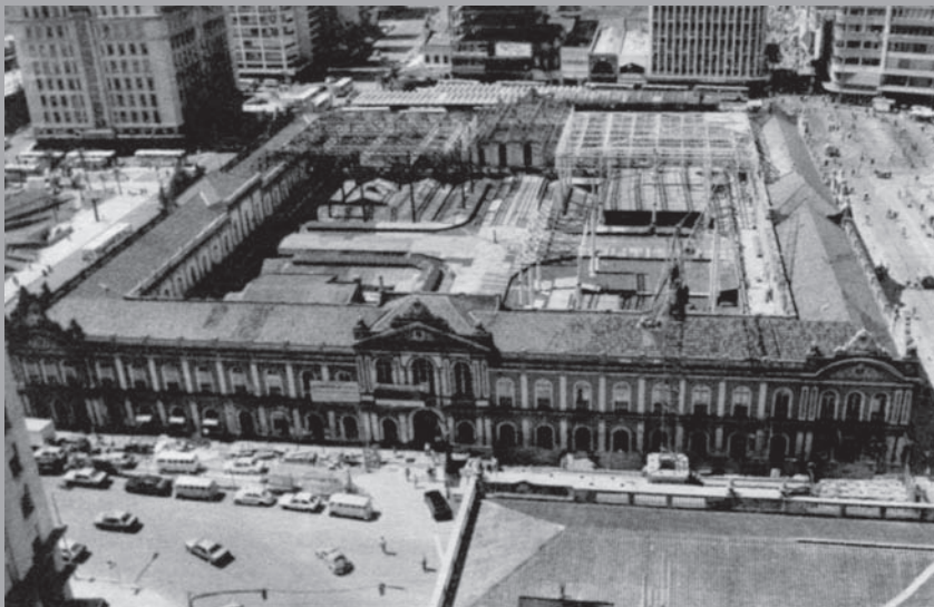
Réhabilitation du Marché Public, immeuble centenaire au centre de Porto Alegre.
