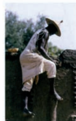
Chantier de reconstruction à Mourla (Cameroun). Construction des rangs supérieurs d'une case, avec appui sur les pose-pieds de rang précédent. Photographie Renaud Guillou, 1997.
