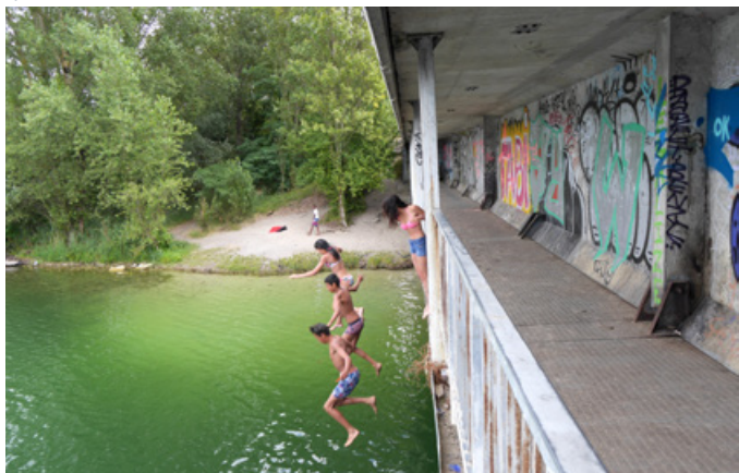
La passerelle plongeur
